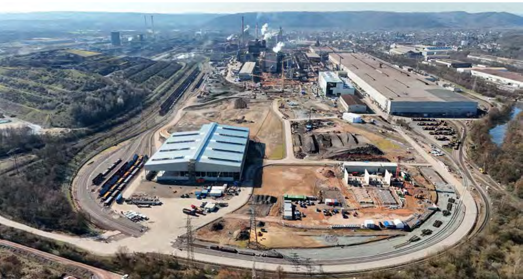
↑ Baufeld Dillingen: Transformationsbaustelle am Standort Dillingen
