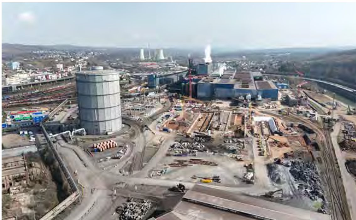
☒ Baufeld Völklingen: Transformationsbaustelle am Standort Völklingen
